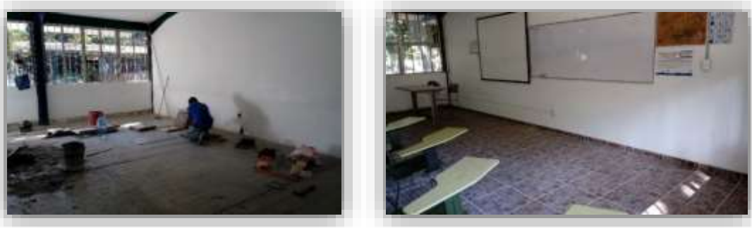
Figura 22. Mantenimiento al piso de las aulas 701 y 702
