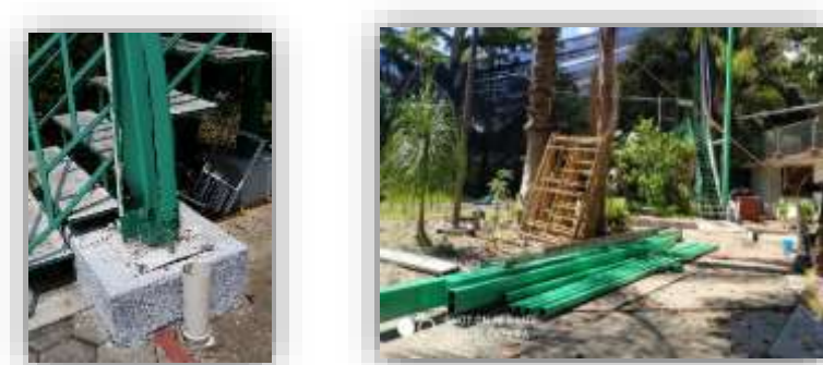
Figura 9. Mantenimiento a la estructura metálica del orquidiario
