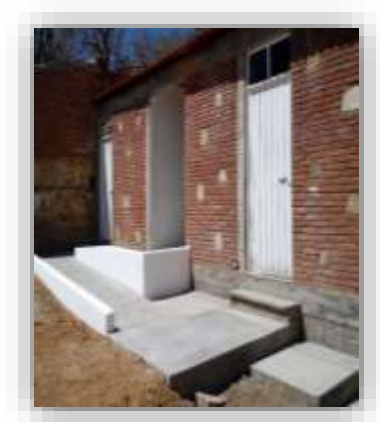
Figura 18. Mantenimiento al acceso lateral del centro de cómputo
