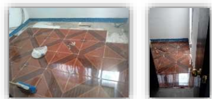
Figura 13. Mantenimiento al piso de la oficina de la jefatura de fomento productivo
