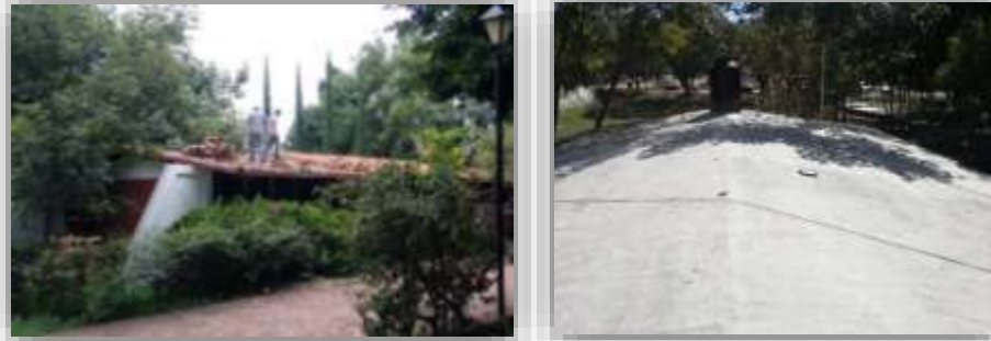
Figura 10. Impermeabilización del edificio I
