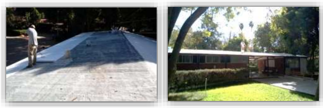
Figura 3. Impermeabilización del edificio H
