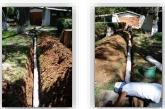
Figura 17. Mantenimiento a la red de drenaje del edificio H
