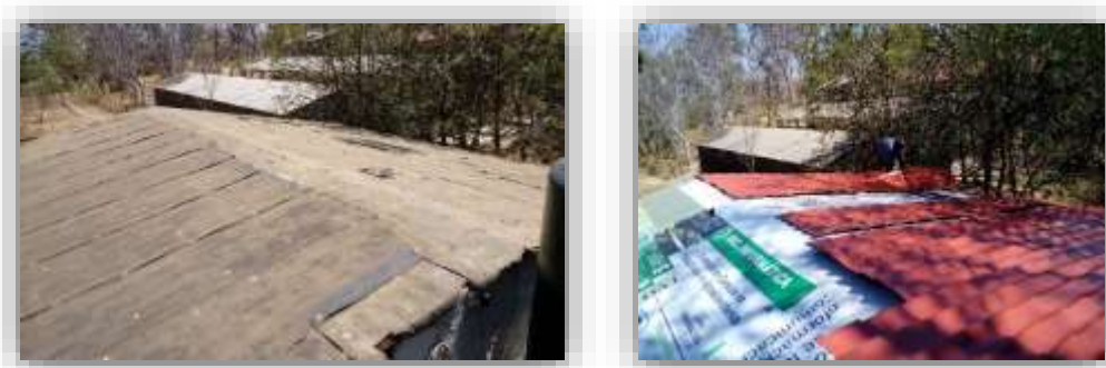
Figura 5. Mantenimiento al edificio de ingeniería forestal
