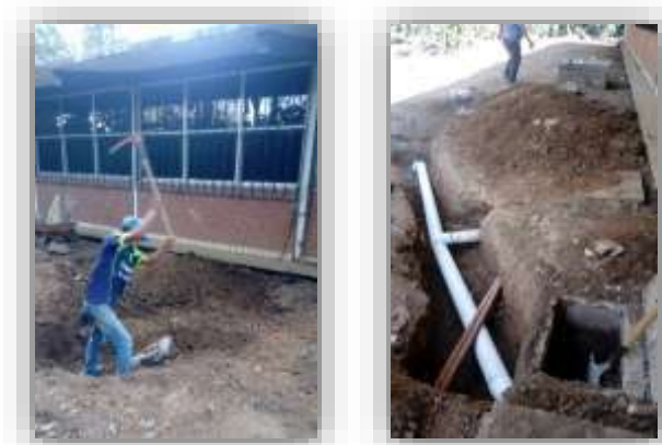
Figura 20. Mantenimiento a la red de drenaje en el edificio 4
