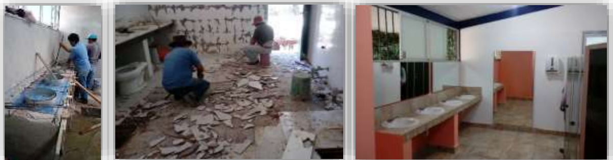
Figura 19. Mantenimiento de sanitarios del área de posgrado
