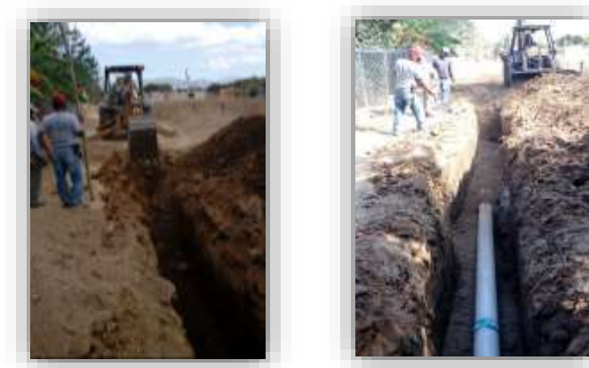
Figura 15. Mantenimiento a la red de drenaje principal del instituto
