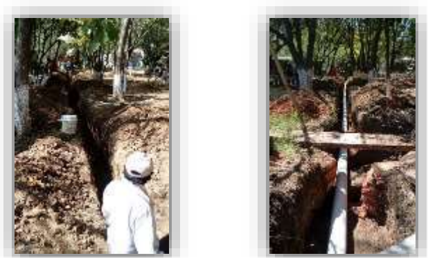
Figura 16. Mantenimiento a la red de drenaje del área de biología
