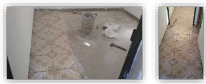
Figura 14. Mantenimiento al piso de la oficina del sector productivo productivo
