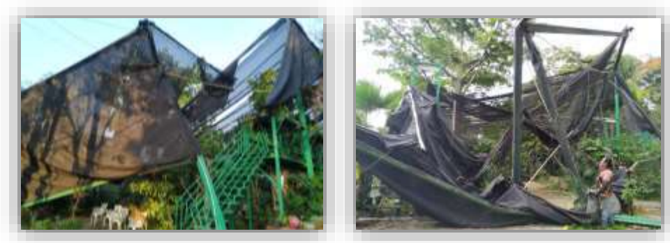
Figura 8. Mantenimiento a la estructura metálica del orquidiario
