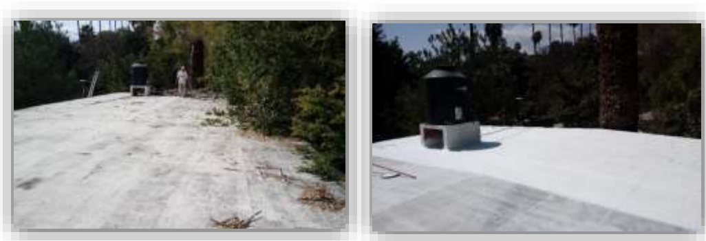
Figura 4. Impermeabilización del edificio V
