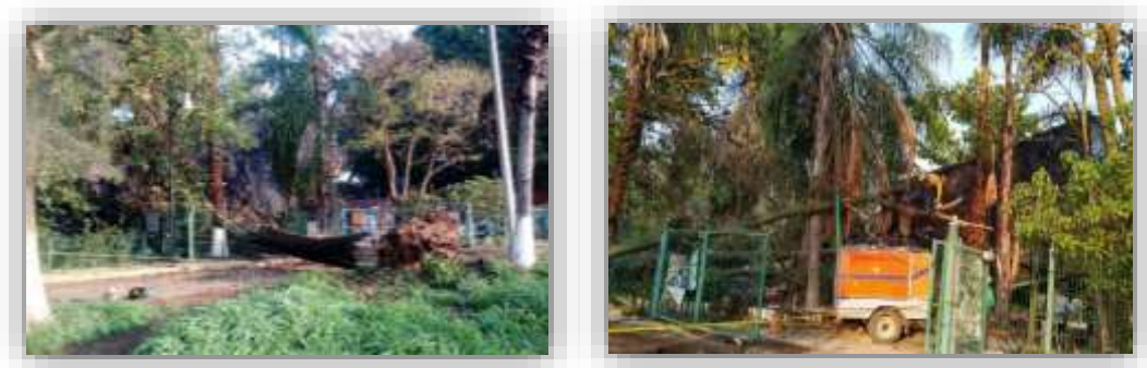
Figura 7. Retiro de árbol caído sobre pabellón de las orquídeas
