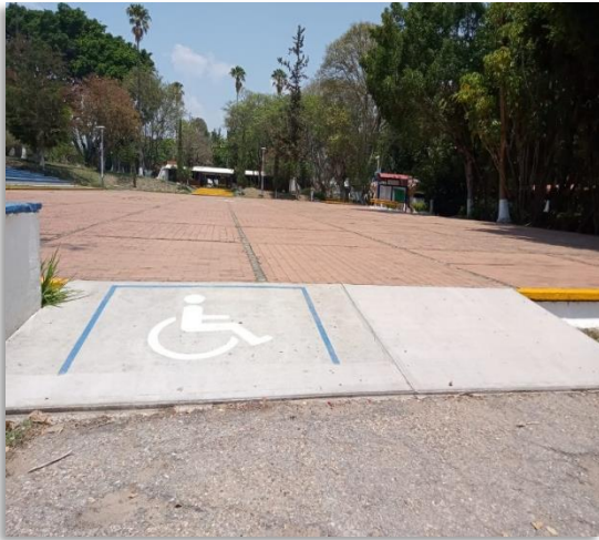
Mantenimiento a rampas.
